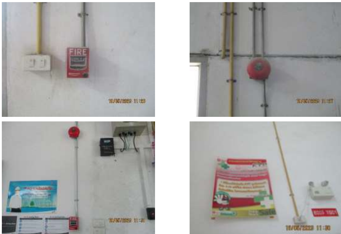
ภาพที่ 2.16 ระบบตรวจสอบตรวจจับ และสัญญาณเตือนภัยแบบอัตโนมัติภายในโครงการ
