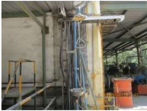
ภาพที่ 2.17 ฝักบัวฉุกเฉินและอ่างล้างตาฉุกเฉินภายในพื้นที่โครงการ
