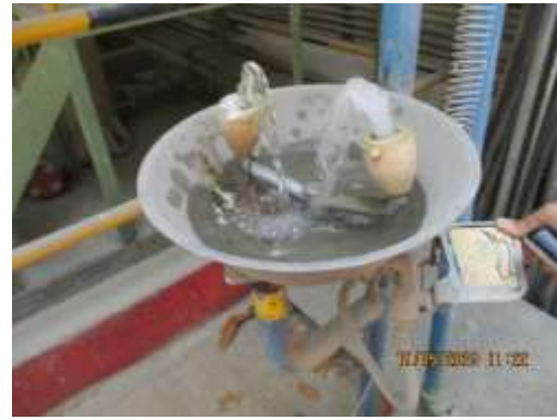
ภาพที่ 2.17 ฝักบัวฉุกเฉินและอ่างล้างตาฉุกเฉินภายในพื้นที่โครงการ
